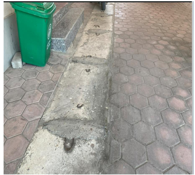
Hình 3. 3. Mương thu gom nước mưa xung quanh nhà điều hành
